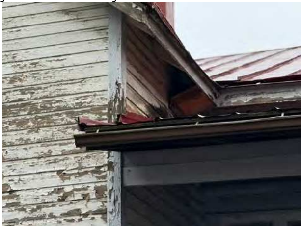
Kuva 36. Julkisivun yläreunaa ja katon liitoksia.
