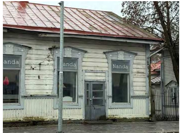
Kuva 47. Vesikattoa ja räystäsrakenteita.
