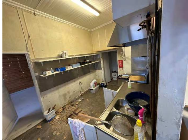
Kuva 11. Yleiskuvaa rakennuksen sisätiloista.
