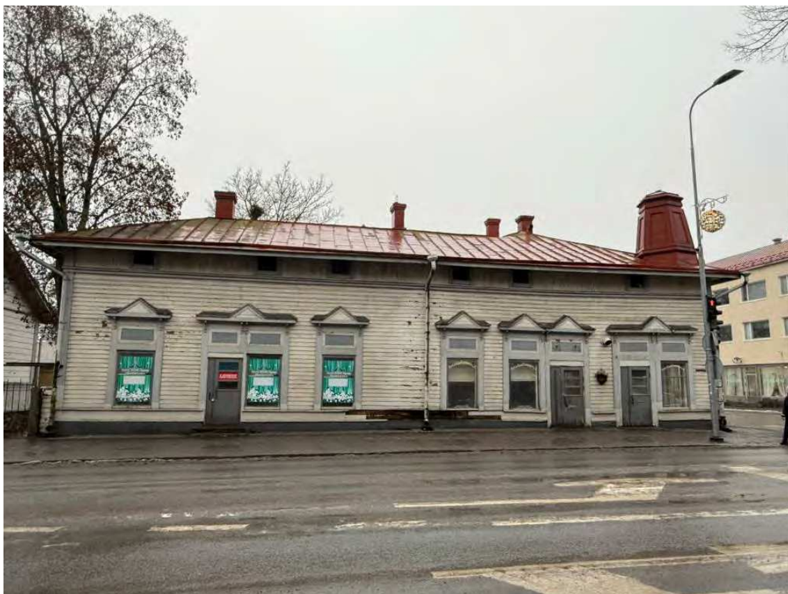
Kuva 18. Savilahdenkatu kulmatalon julkisivu joulukuussa 2025.
