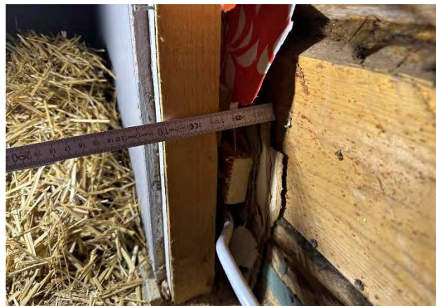
Kuva 65. Ulkoseinän sisäpuolista rakennetta.
