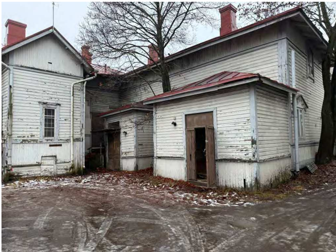
Kuva 21. Kulmatalon sisäpihan kulma ja sisäänkäynti rakennuksen vanhimpaan osaan. Kuva 2025.
