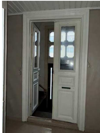
Kuva 29. Mikonkatu kulmatalon sisäänkäynti päädyssä vanhat ovet ovat säilyneet. Kuva 2025.
