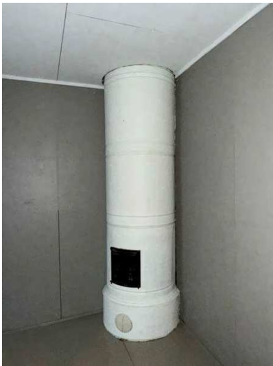
Kuva 28. Pöytäuunia ja nykyisiä lastulevyseiniä, Mikonkatu kulmatalo. Kuva 2025.
