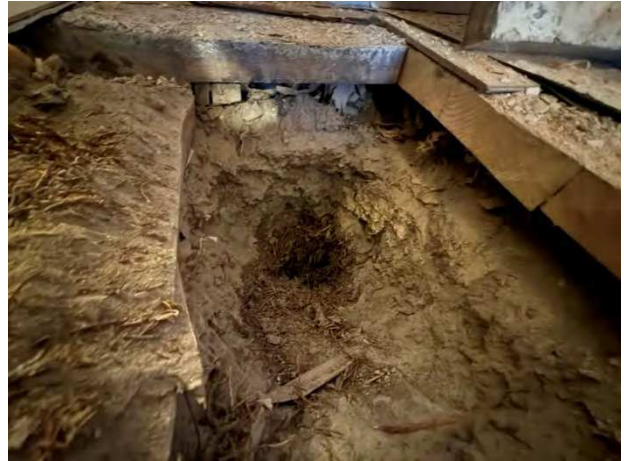
Kuva 31. Alapohjan täyttöä.
