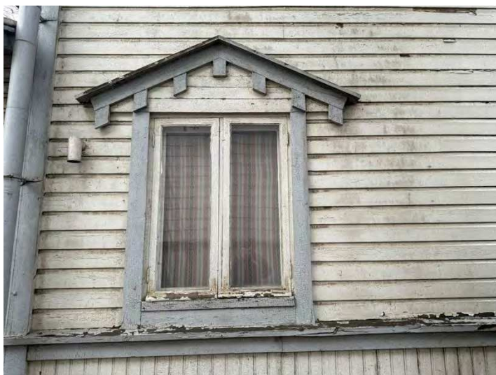
Kuva 55. Nykyistä ikkunalistoitusta leivintupa 2025
