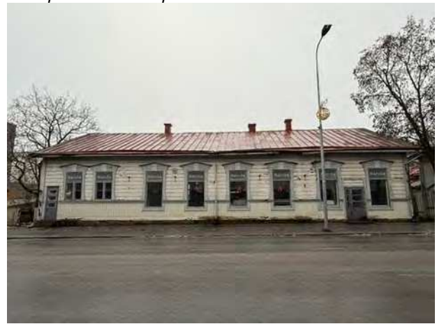
Kuva 43. Tien puolen julkisivua.
