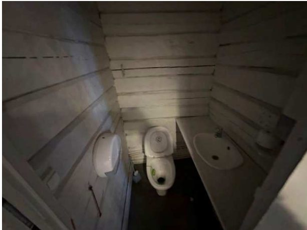
Kuva 14. Yleiskuvaa rakennuksen sisätiloista.
