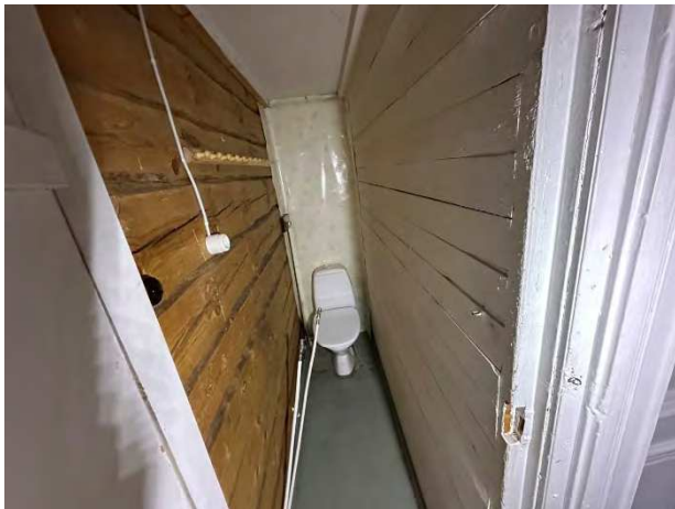
Kuva 54. Yleiskuvaa rakennuksen sisätiloista.
