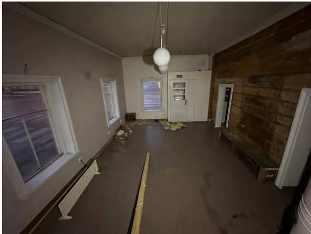
Kuva 48. Yleiskuvaa rakennuksen sisätiloista.
