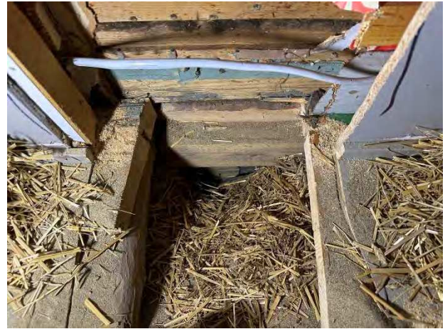
Kuva 73. Alapohjan eristeenä olkea, hiekkaa, turvetta yms.
