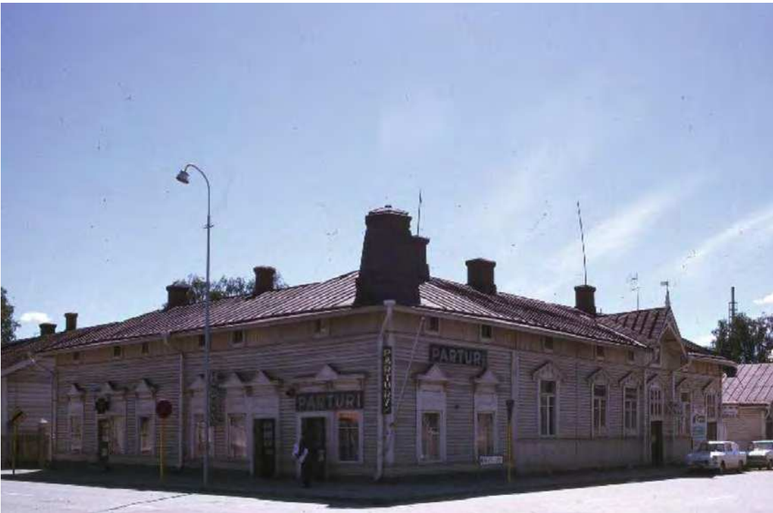
Kuva 15. Pulkkisenkulma vuonna 1970. Savilahdenkadun ja Mikonkadun kulmarakennuksen vanhin hirsirakenteinen osa on rakennettu vuonna 1843. Kuva Markku Paappanen
