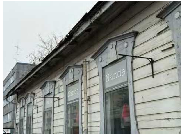
Kuva 45. Räystäärakenteiden lahovaurioita.
