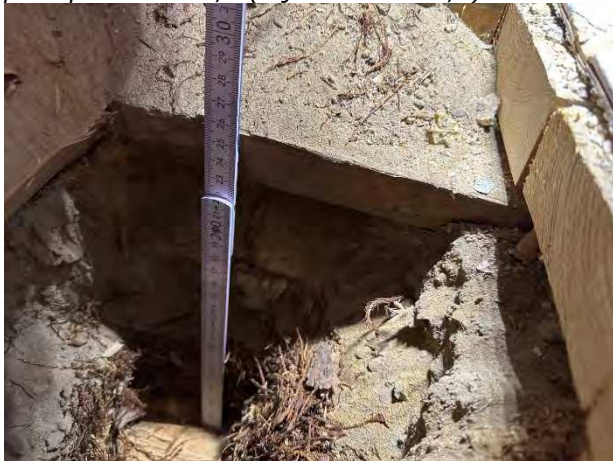
Kuva 28. Alapohjan eristepaksuus on n. 260 mm
