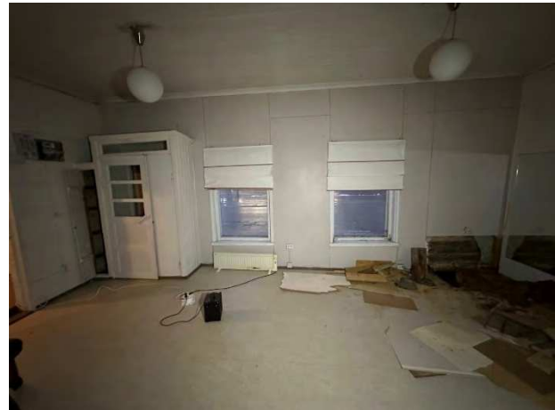
Kuva 49. Yleiskuvaa rakennuksen sisätiloista.
